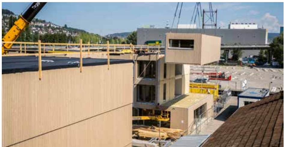
Montage der Holzmodule auf dem FOGO-Areal. BILD: PIRMIN HENSELER
