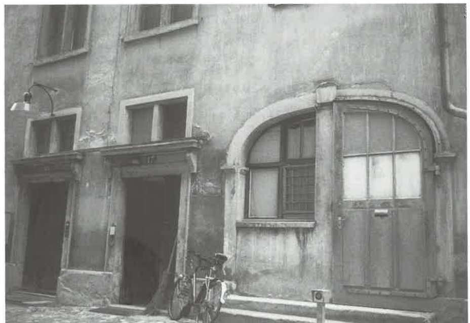
Gegenwärtig präsentiert sich die Liegenschaft Sihlramtstrasse 15/17 noch in recht verwahrlostem Zustand.
