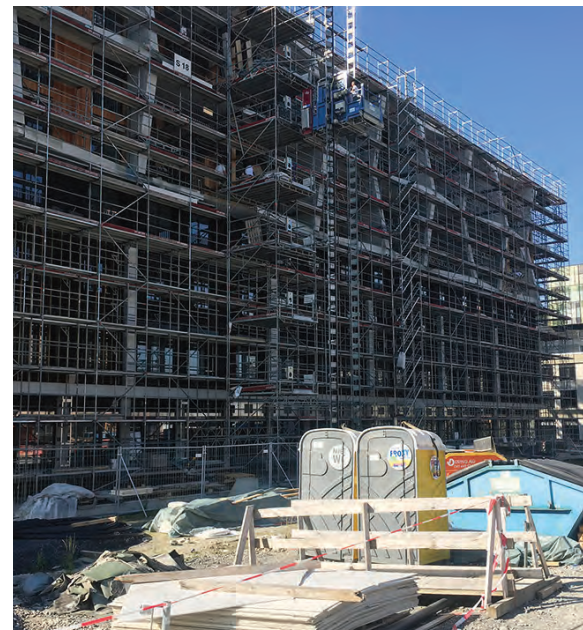
Baustelle: das Haus mit den Juwo-Zimmern nimmt Form an.
